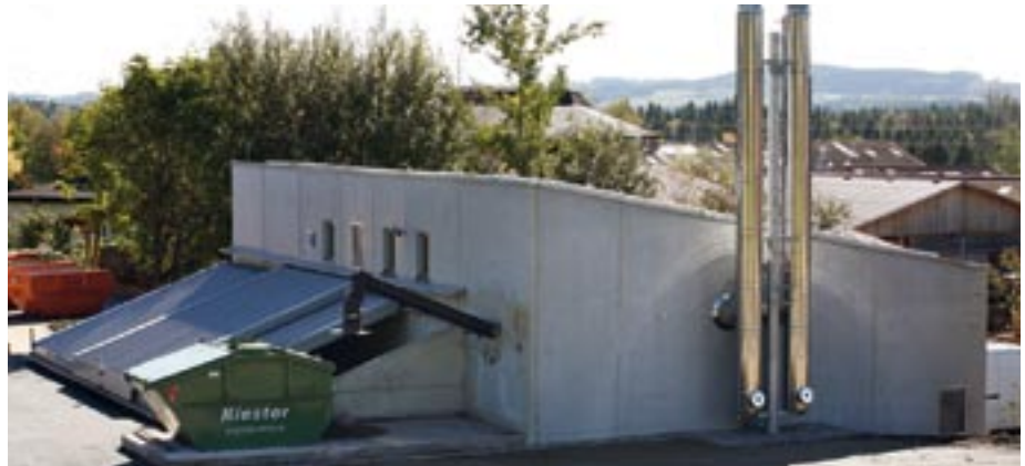
Die Holzhackschnitzelanlage ist bereits erfolgreich im Einsatz.
